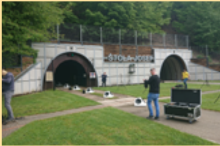
Příprava na akustické měření v tunelu
