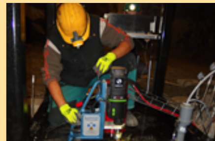
Odebírání vzorku z bentonitové vrstvy u IB 200C
