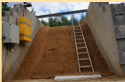
Hráz pokrytá ochrannou geotextilií
