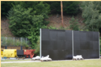
Protihluková stěna vystavěná v areálu štolý Josef
