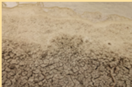
Detail těsnící vrstvy vystavené klimatickým vlivům
