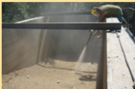
Nástřík hráze těsnící bentonitovou vrstvou
