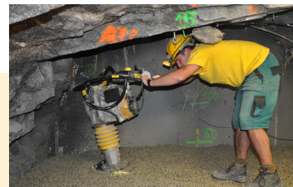
Hutnění bentonitových pelet v těsnící vrstvě
