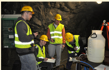
Tlakové zkoušky v jádrovém vrtu v praxi
