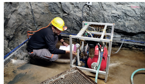
Údržba čerpadla v PVP Bukov
