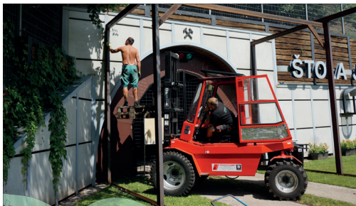
Výstavba variabilní portálové konstrukce
