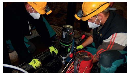
Odběr vzorku jádrovým vrtáním
