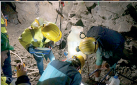
Průběh tlakové zkoušky ve vrtu
