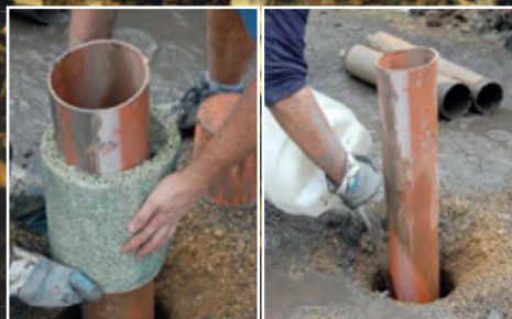
Instalace bentonitového těsnění
