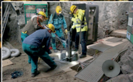
Hutnění vrstvy z bentonitových pelet
