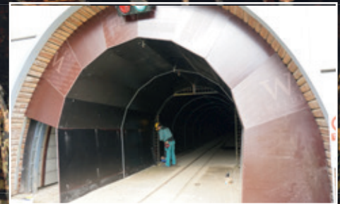
Téměř dokončený portál „tunelu v tunelu“
