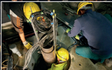
Instalace čidel v průběhu výstavby modelu
