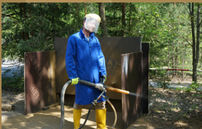
Nácvik technologie stříkaného bentonitu
