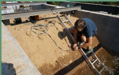
Měření propustnosti hráze
