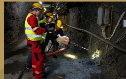
Vrtání do skály – práce pro silné muže
