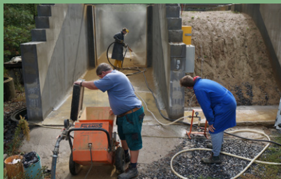
Nástřik bentonitové vrstvy
