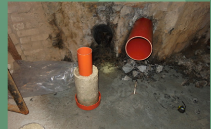
In situ test umístění těsnicího prvku do vrtu
