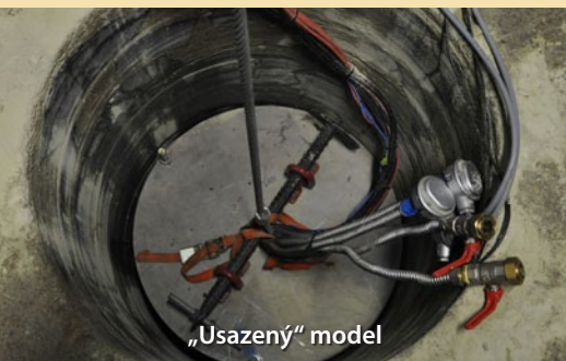
Spouštění do úložné studny
