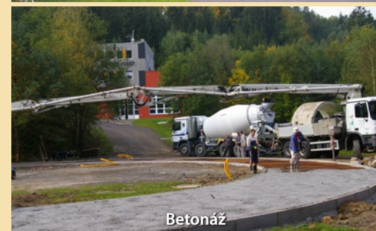
Příprava betonáže kruhové dráhy
