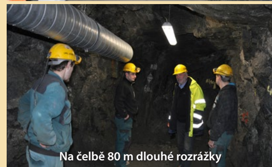
Montáž nuceného větrání
