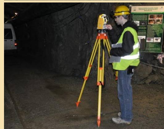
Vytyčování na hlavním překopu Mokrska západ
