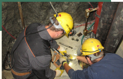
Odběry vzorků z bentonitové bariéry
