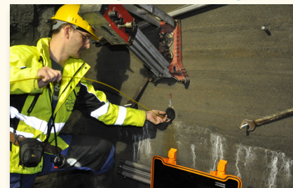
Jádrový vrt v rozrážce pro budoucí laboratoř
