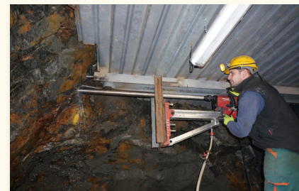
Úprava „zastřešení“ jeviště v katedrále
