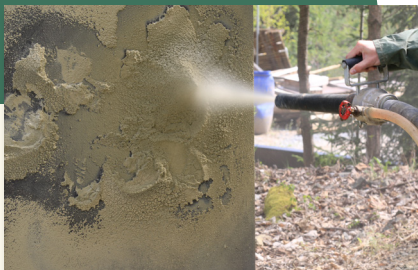
Ukázka technologie stříkaného bentonitu
