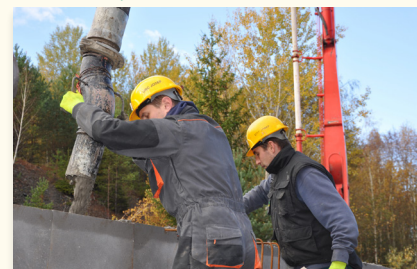
Betonáž do ztraceného bednění
