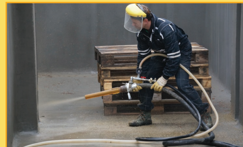
Zkušební test technologie stříkaného bentonitu
