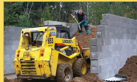
Výstavba modelu hráze rybníka
