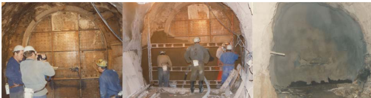
Obr. 4.9 Fáze nástřiku zátky
