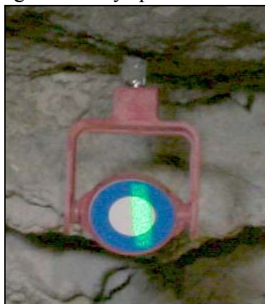
Obr. 12.7 – Stabilizace a signalizace identických bodů
