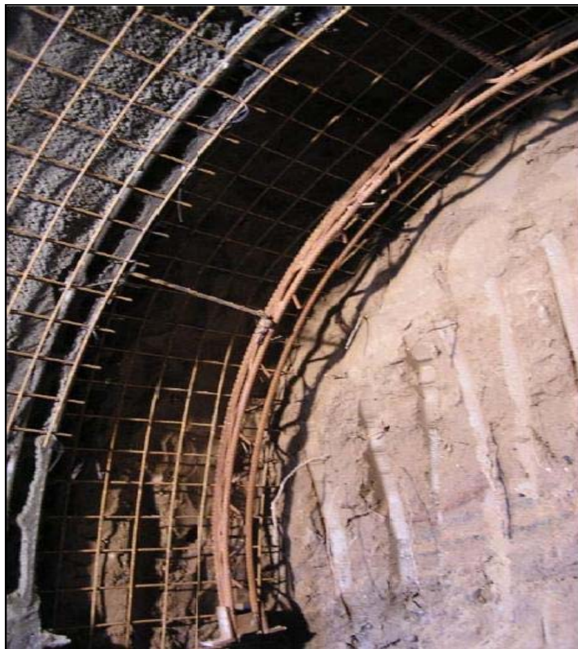
Obr. 6. 20 Výztužné síť a příhradová žebra před zastříkáním betonem
